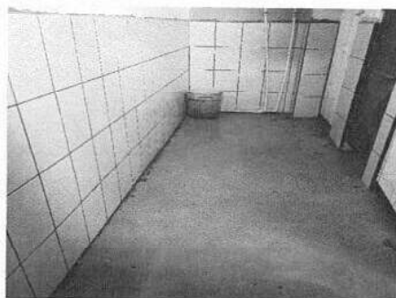
Foto 3: MÓDULO 1: Vista de la pared azulejada de los baños.
