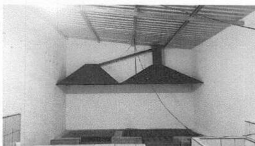
Foto 3: MÓDULO 2: Se fabrico la parrilla y la chimenea, para desfogue del humo.
