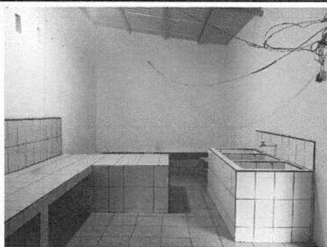
Foto1: MÓDULO 2: Vista de la nueva pila de la cocina juntamente con los gabinetes y poyeton con su azulejo.
