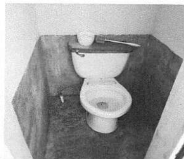
Foto 4: MÓDULO 1: paredes de los baños remodeladas.
