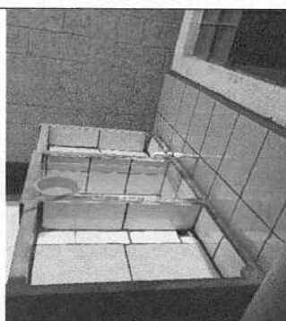
Foto 5: : MÓDULO 2: Vista de la pila reparado para uso de la escuela.
