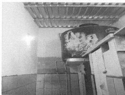
Foto 1: MÓDULO 1: Vista de la nueva estructura y entechado de los baños.
