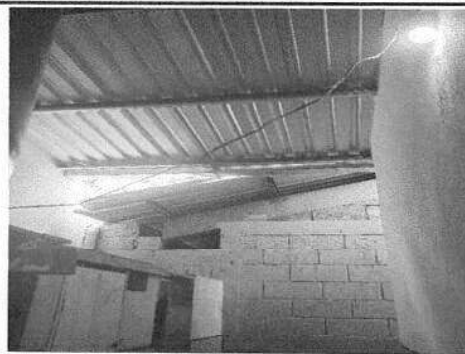
Foto 2: MÓDULO 1: Vista del nuevo entechado de los baños.
